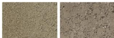
Facciavista Da intonacare
